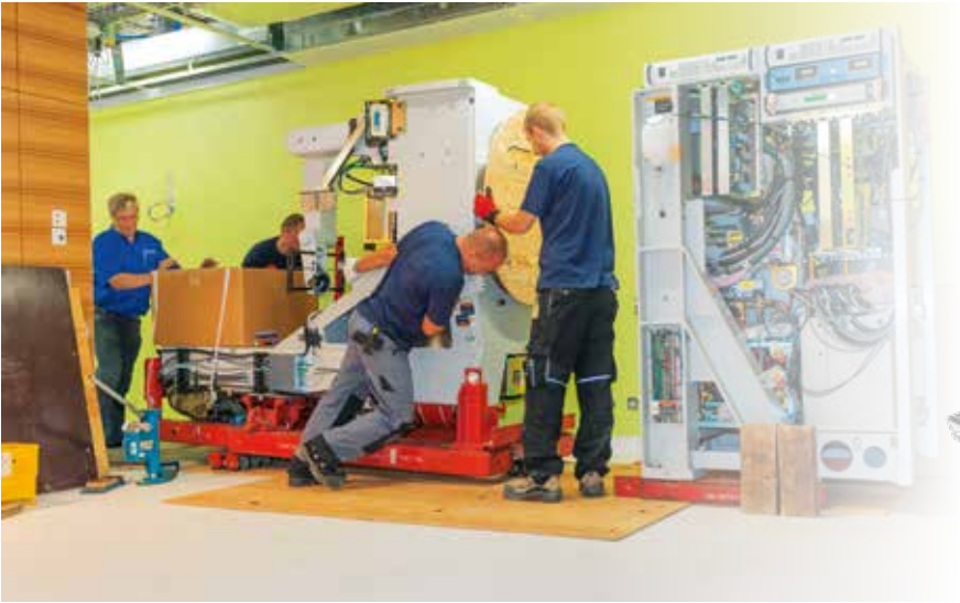
Manutention de la porte blindée de la nouvelle salle de radiothérapie et plan en 3D des sous-sols de la clinique réhabilités dans le cadre de Domino.
