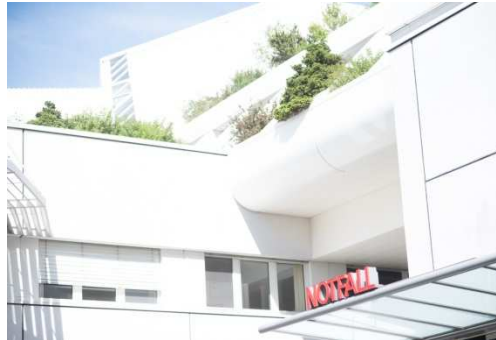
Das Notfall Zentrum der Hirslanden Klinik Aarau wurde erweitert und modernisiert
