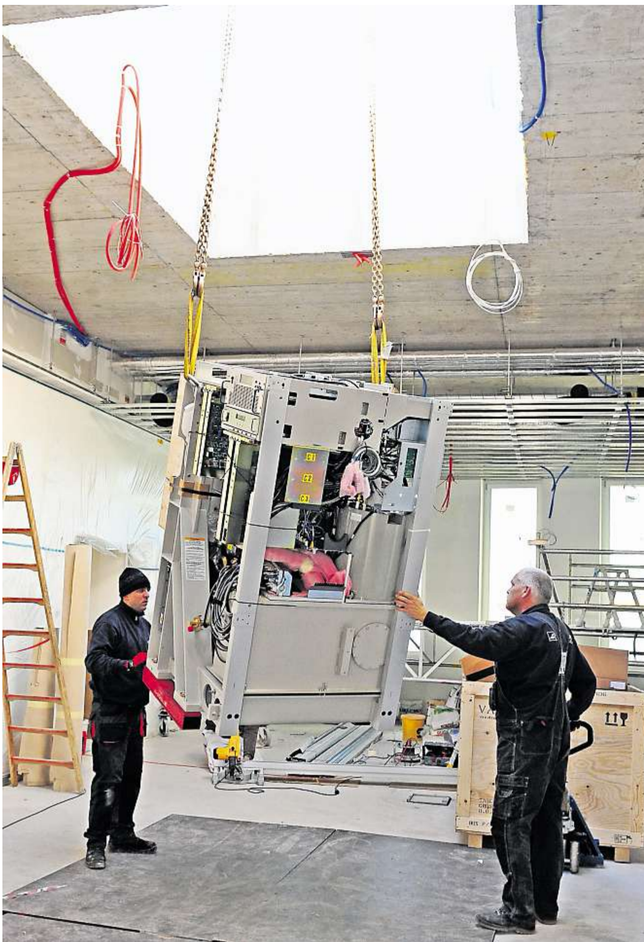
Der Linearbeschleuniger wurde für den Transport in drei Teile zerlegt. Der hintere Teil wiegt 3,5 Tonnen. Bild: Kurt Heuberger
